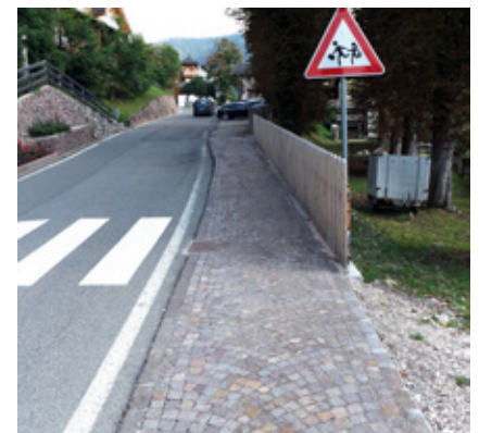
Gehsteig beim Bacherhof
