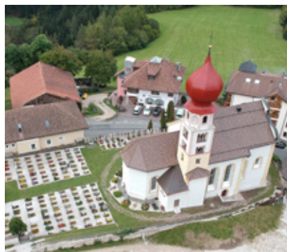
Sanierte Pfarrkirche Tiers
