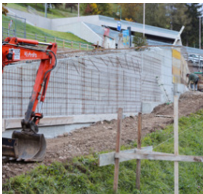
Plaug WBZ Beginn Arbeiten
