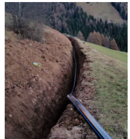
Erneuerung Trinkwasserleitung Tiers
