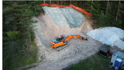
Aushub Kraftwerk Lippen
